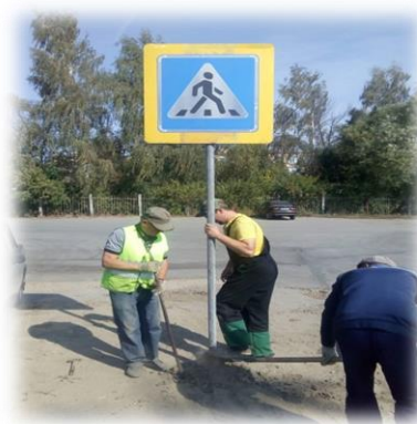
Установка дорожных знаков
