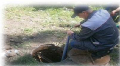
Очистка канализационных сетей
