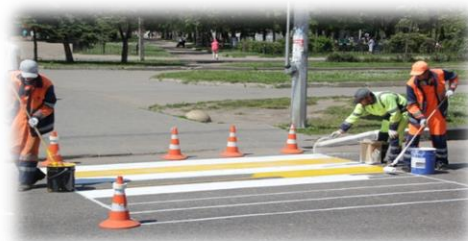
Нанесение дорожной разметки
