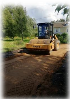
Ремонт по ул. Привокзальная
