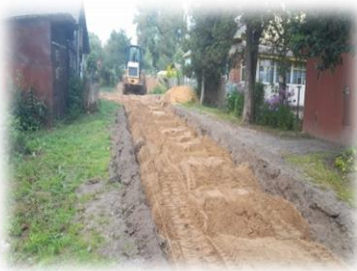
Ремонт по ул. Тяговая
