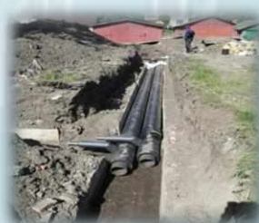
Капитальный ремонт тепловых сетей.
