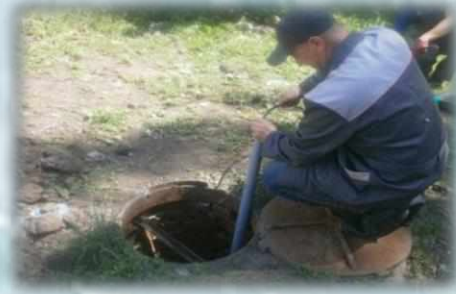
Очистка канализационных сетей
