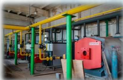
Техническое перевооружение котельной СМУ-11
